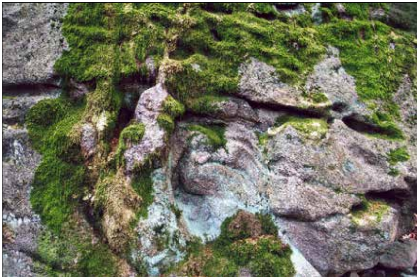
Foto 4: Skalní stěna na severním svahu Wyniosła s dutinovými mikroformami výběrového zvětrávání a odnosu granitoidů (k článku na str. 3). Foto 1–4 Jan Vítek.
