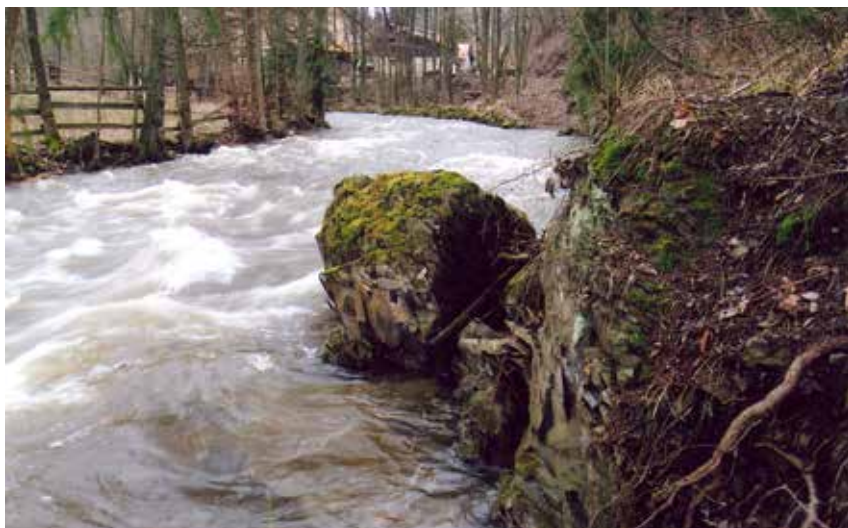
Foto 4: Levý nárazový břeh Zdobnice v jiv. části meandru u osady Pekelec (část Rybné nad Zdobnicí) se zříceným slínovcovým blokem (k článku na str. 3). Foto 1–4 J. Vitek.
