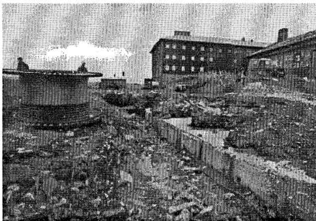
Obr. 8: Detail strženého výmolu se zbytky stavebního materiálu. V této partii je nutné zavezení autochtonní zeminou a zatravnění původními druhy. Foto z 3. 9. 1994 Z. Málek.
