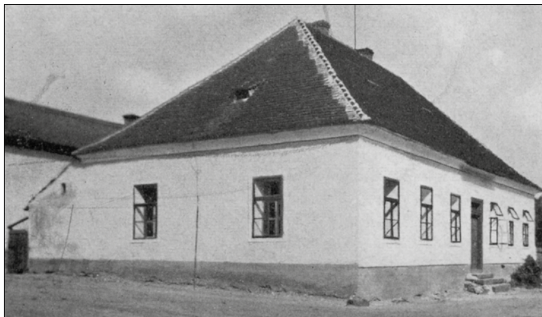
Obr. 3: Budova německé školy ve Veské. Zdroj: Beranek, 1954
