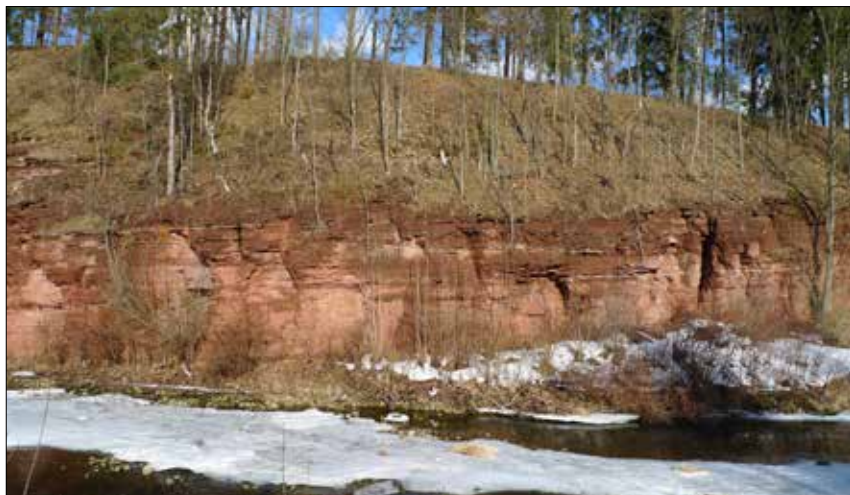
Foto 14: Střední část 2. skalního defilé za zimní oblevy. Partie skalních stěn silně zvlhčené vodou tajícího sněhu (tmavěji zbarvené), podléhají při následném zmrznutí silněji kongelifrakci (k článku na str. 47).
