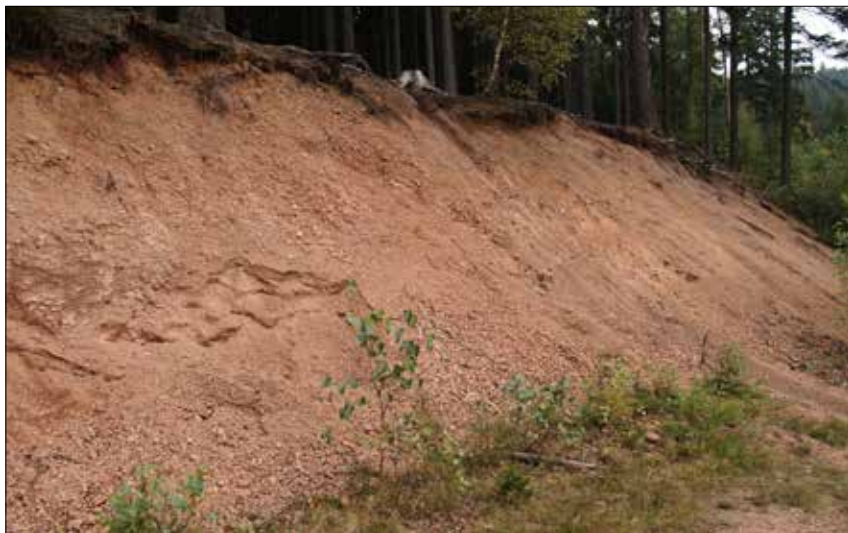
Foto 3: Odkryv granodioritové zvětraliny (saprolitu) na j. svahu vrchu Háj mezi Borovou a Novým Hrádkem (k článku na str. 3).
