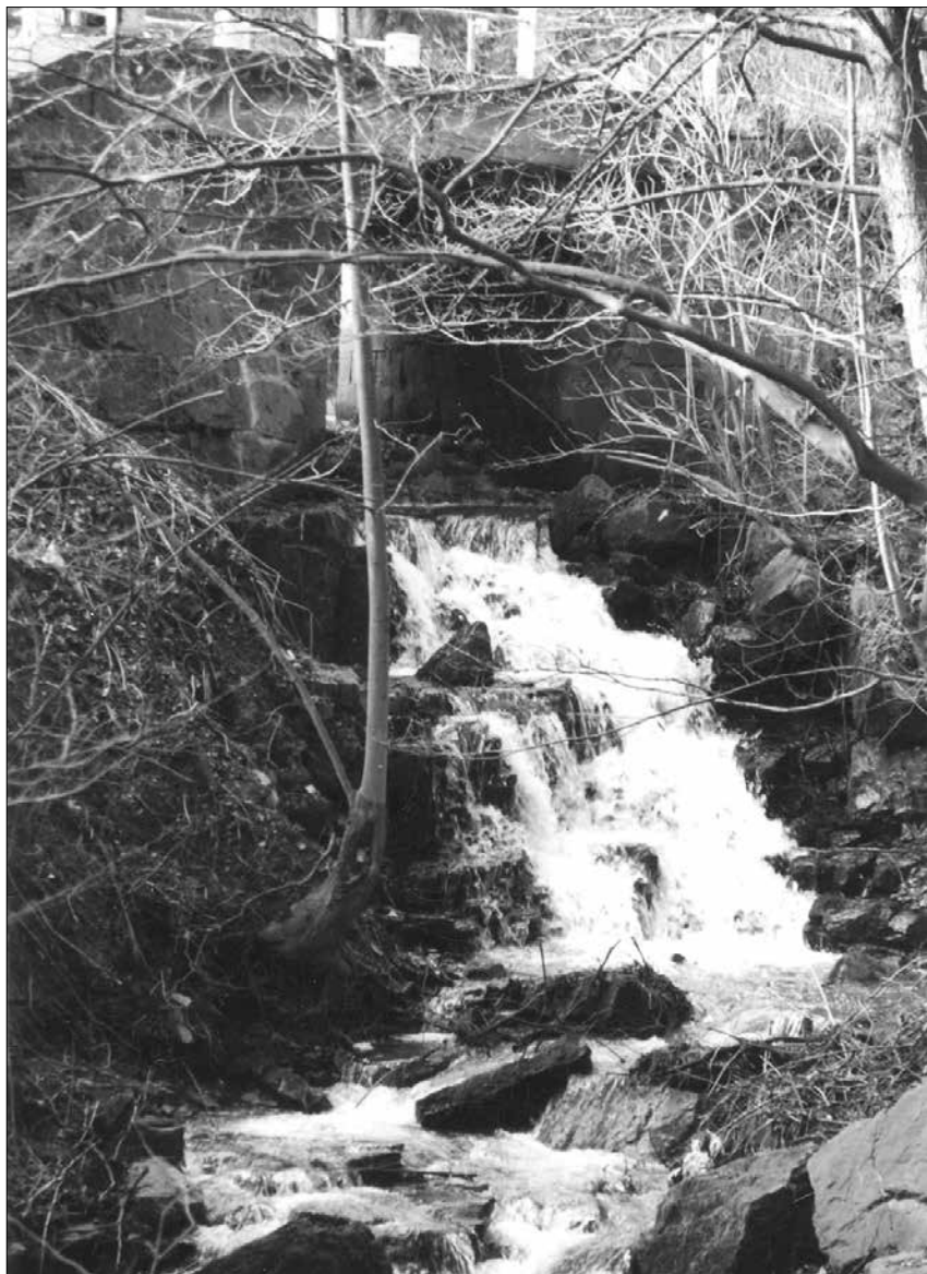
Obr. 7: Hlavní kaskáda Slatinského potoka pod silničním můstkem.
