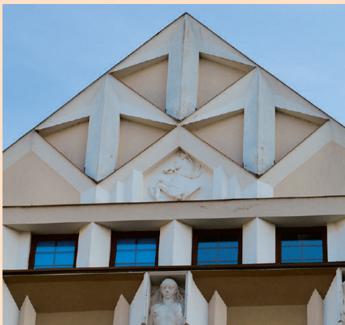
Štít jednoho z nouzových obytných domů města Pardubice na Čechově nábřeží čp. 527, realizace 1922–1923, architekt Oldřich Liska
