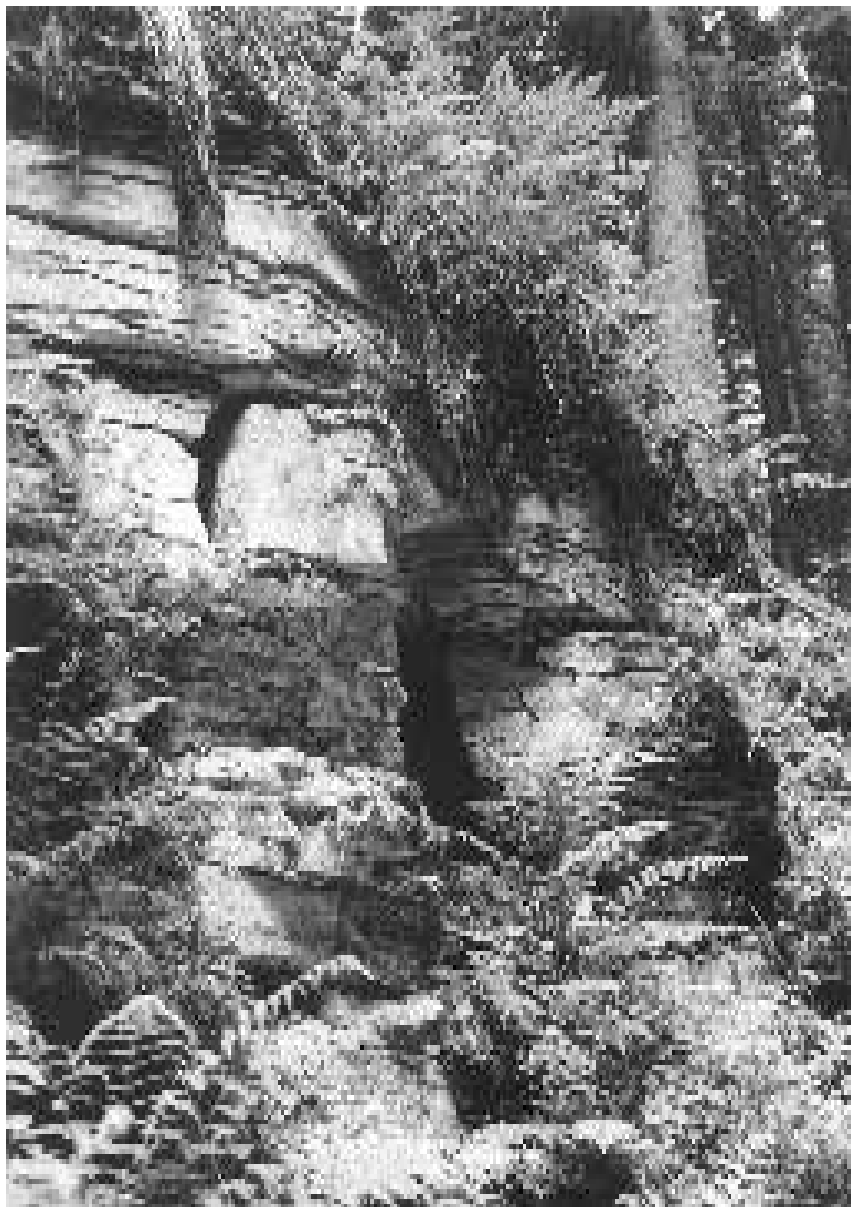
Obr. 5: Tvary zvětrávání a odnosu opuk dle puklin a různě odolných vrstev. Fig. 5: Forms of weathering and denudation of the marlites.
