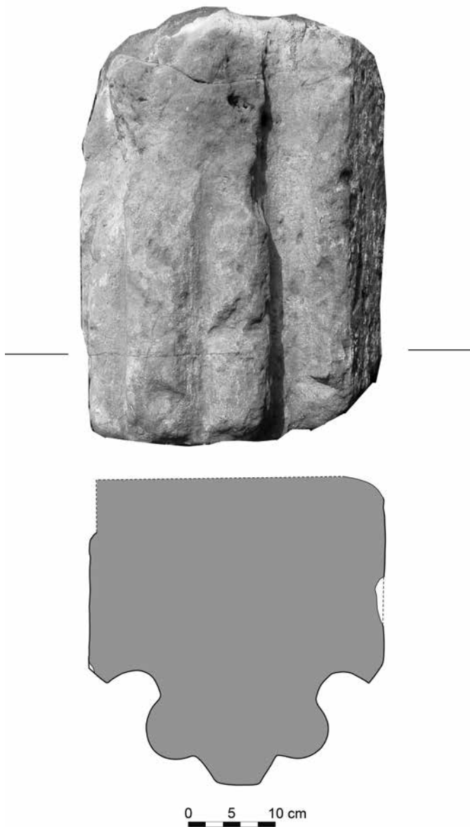
Obr. 7: Lichnice (k. ú. Podhradí v Železných horách, okr. Chrudim). Raně gotické okenní ostění a jeho profilace. Zaměření a foto M. Kovář, překreslila H. Kovářová, upravil J. Musil (2017).
