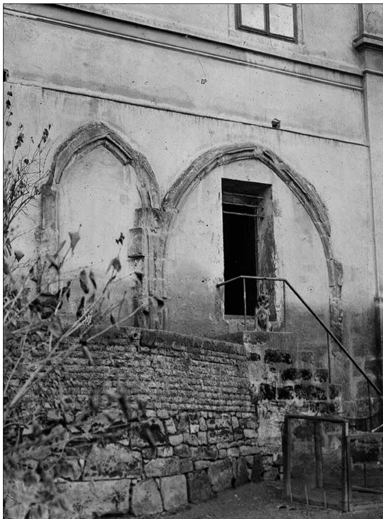
Obr. 5: Chrudim, Všehrdovo náměstí. Pohled na druhotně užitě architektonické články snad z kostela či křížové chodby zazděné v budově v areálu Police ČR. Za povšimnutí stojí i zeď patrná v dolní části snímku, kde nalezneme další pískovcové prvky. Snímek ze sbírek RM v Chrudimi.
