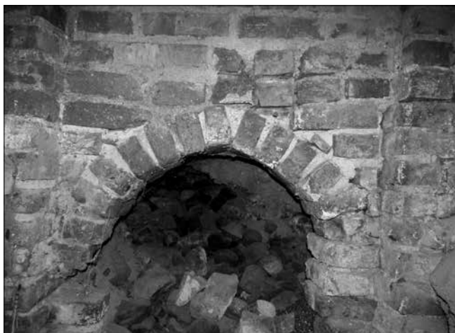
Obr. 10: Žebrák (okr. Beroun). Hrad. Pohled na čelní stěnu topeniště akumulčního centrálního teplovzdušného vytápěcího systému tzv. starého paláce. Zřetelné jsou valouny, představující akumulční složku, které jsou nepochybně součástí destrukce náznakově rekonstruované horní části zařízení nad topnou komorou.
