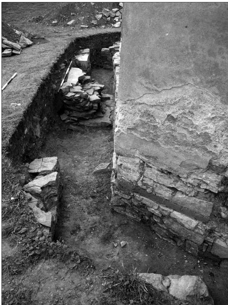
Obr. 24: Chrast-Chrašice, kostel sv. Martina. Sondy 4 až 7. Pohled na zachovaná torza zdiva gotického presbytáře (909). Trasírka je položena na zdivu mladšího soklu (910). Foto J. Frolík.
