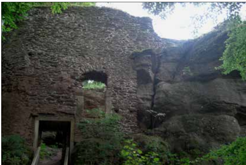
Obr. 6: Vstupní obvodové zdivo hradu Břecštejna vestavěné do slepencové skály. Fig. 6: Entrance peripheral stonework of Břecštejn castle built in a conglomerate rock.
