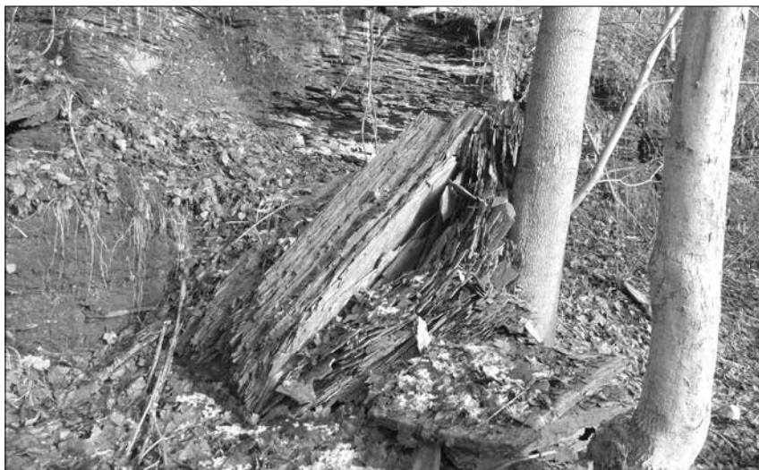
Obr. 11: Zřícený skalní blok na úpatí 4. skalního defilé se zastavil o kmen stromu a následně se mrazově rozpadá podél velmi tenké vrstevnatosti.
