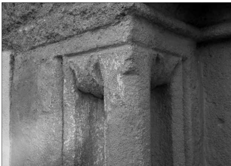
Obr. 6: Vážany nad Litavou (okr. Vyškov). Kostel sv. Bartoloměje. Detail zakončení prutu ostění severního portálu lodi. Srovnej obr. 5. Foto M. Kovář 2020.
