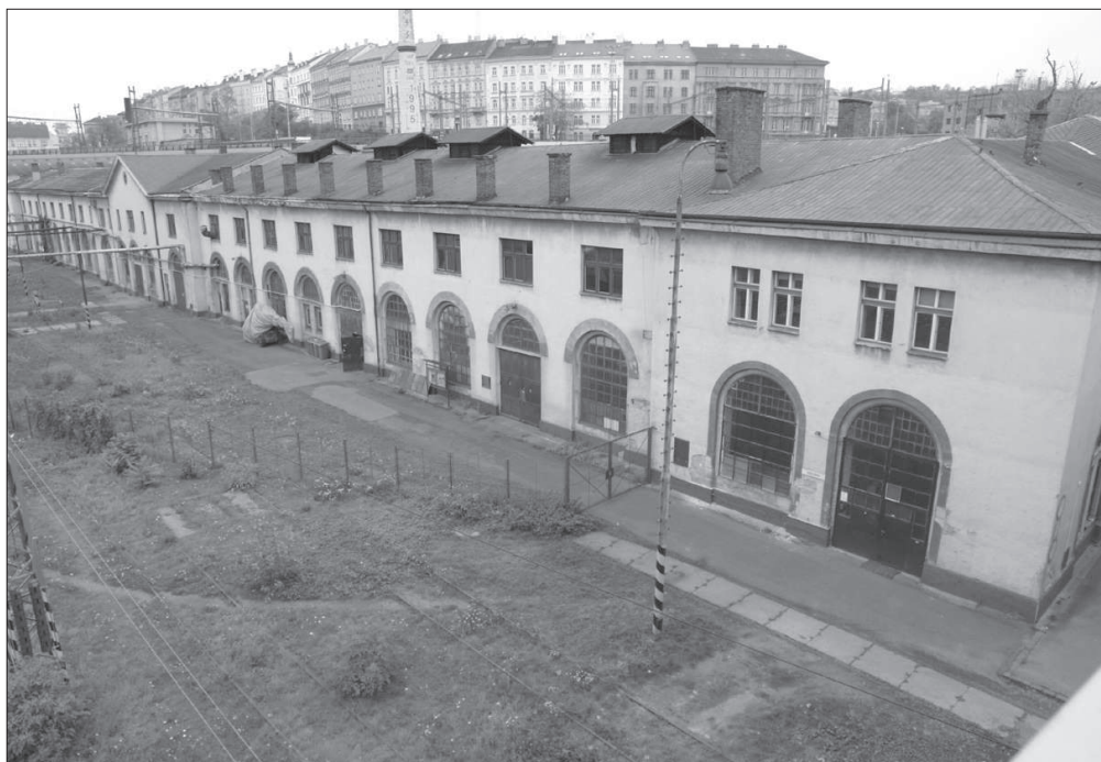
Obr. 1: Praha – Masarykovo nádraží, fotografie dnešního stavu hlavního křídla budovy někdejších strojních dílen ve východní, provozní části areálu, postavených k zahájení provozu na olomoucko-pražské dráze v roce 1845 (pohled od severozápadu z estakády II. severojižní magistrály nad kolejíštěm nádraží). Za střední částí budovy vyčnívá komín nad jižním výběžkem s kotelnou, v pozadí na terénní hraně linie činžovních domů na západním okraji Žižkova.
