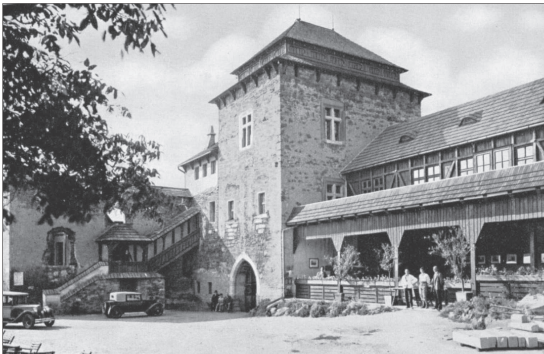
Pohled z hradního nádvoří na 6. bránu po úpravách provedených Kunětickým družstvem. SOKA Pardubice, Sběrka fotografií a negativů.
