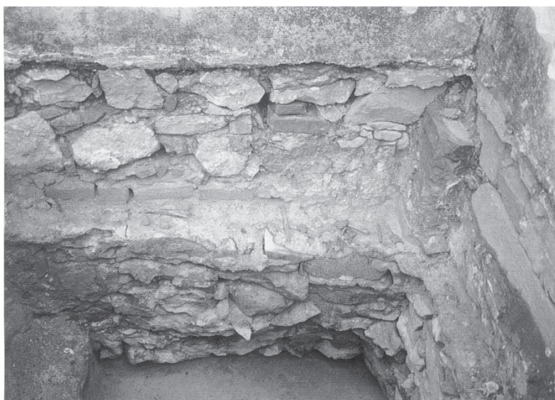
Obr. 2: Kostel sv. Jiljí - S1 - zdivo základu presbytáře
