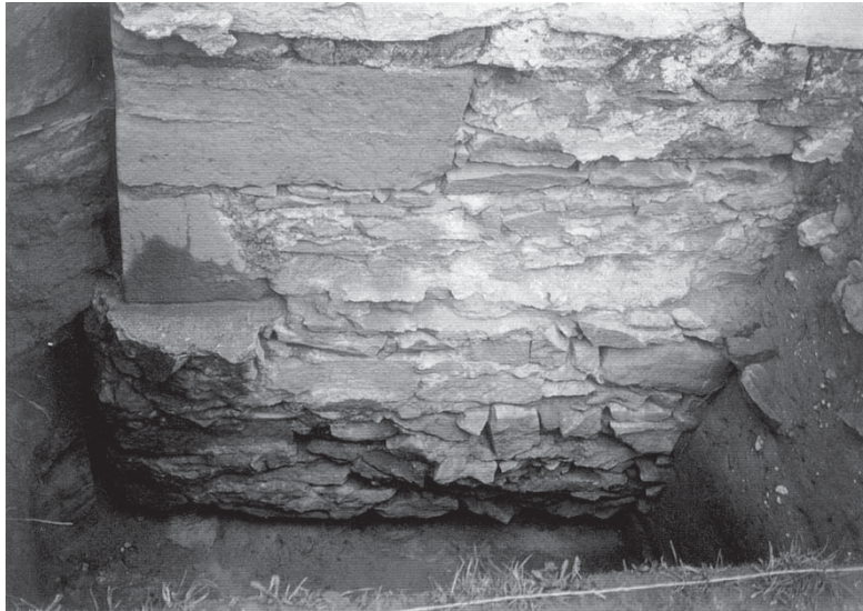
Obr. 5: Kostel sv. Jiljí - S3 - zdivo základu
