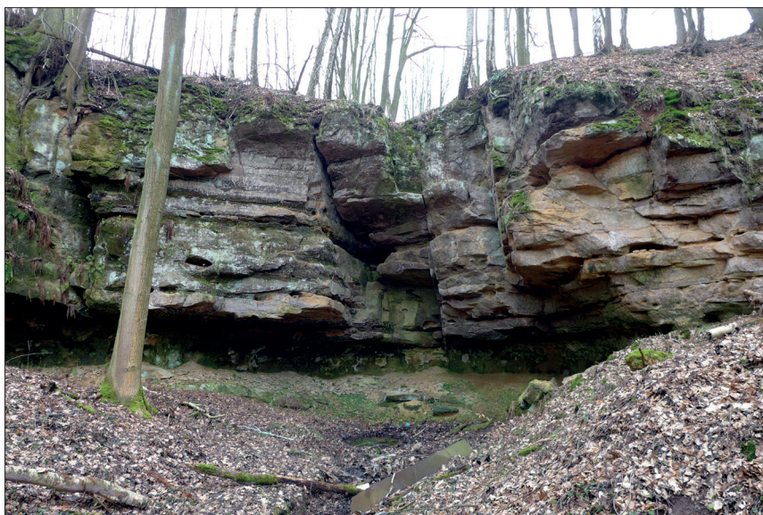
Obr. 9: Mimořádně silně členitá stěna Záhorského vodopádu. Silně porézní úpatní vrstva pískovců podléhá intenzivní gelivaci.
