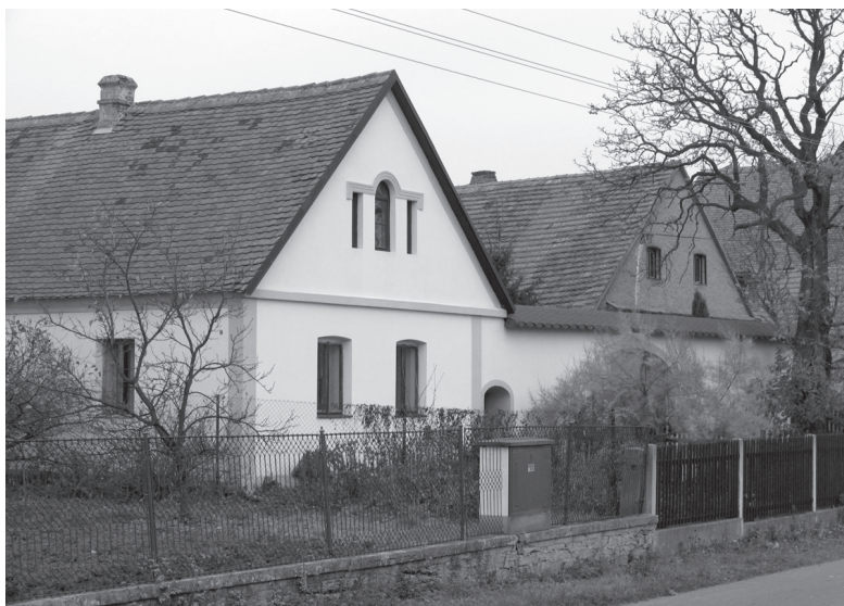
Selské stavení ve Stradouni. Foto autor, 2005.
