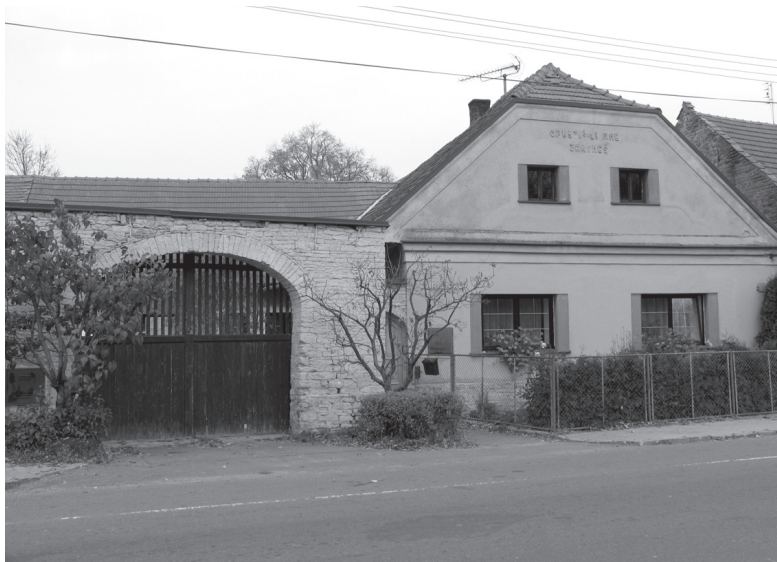
Selské stavení ve Stradouni, nápis na štítě hlásá „Opustíš-li mne, zahyneš“. Foto autor, 2005.
